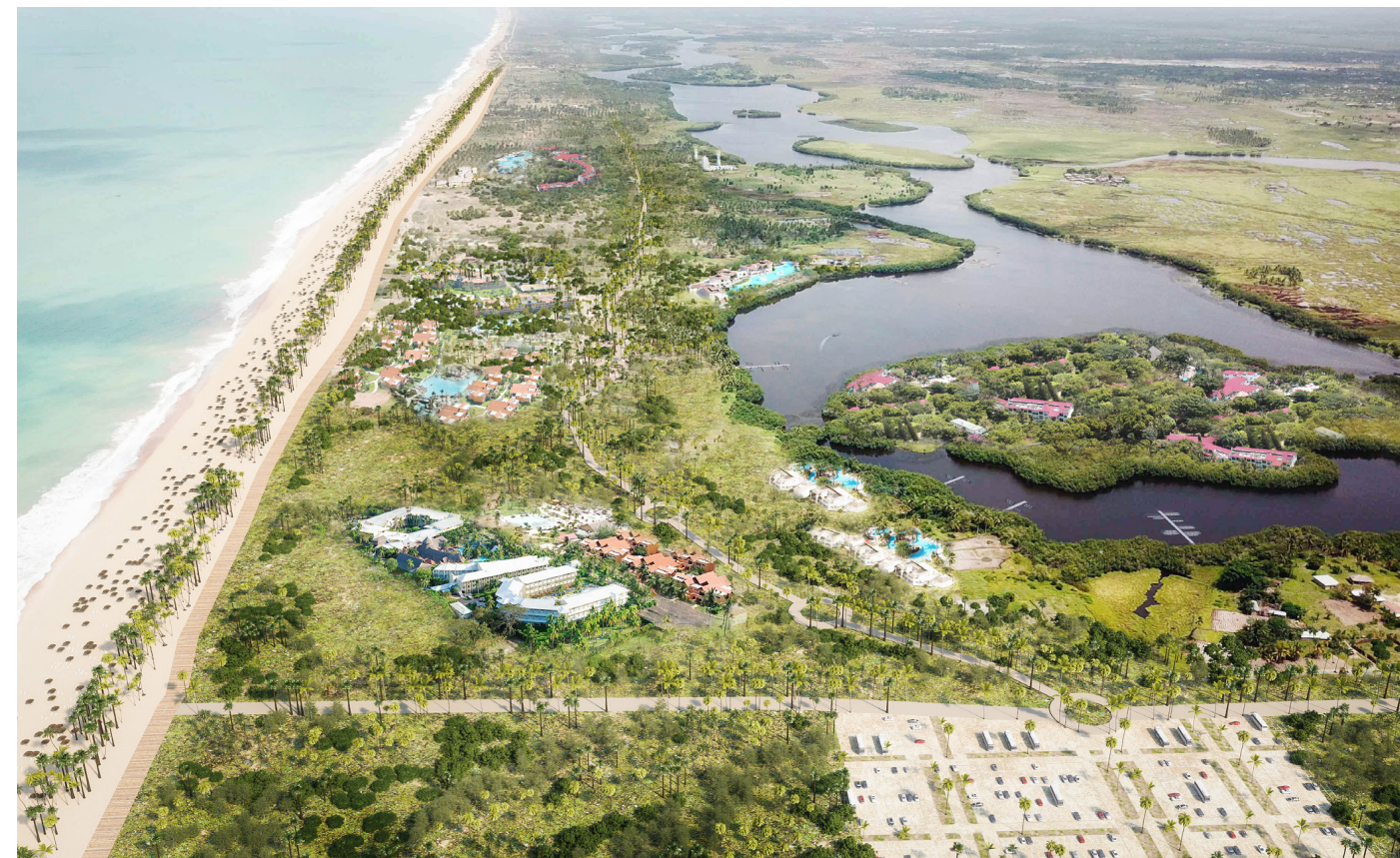
Ouvrage : Reaménagement des berges maritime et lagunaire Mission : Planification, conception des aménagements et programmation Maîtrise d'ouvrage : Agence Nationale de promotion des Patrimoines et de développement du Tourisme (ANPT) Localisation : Togbin Plage, Bénin Année : 2019
